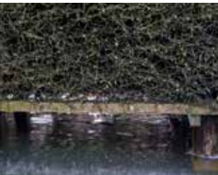
Gradierwerk der Saline Gottesgabe: Die Sole tröpfelt durch die Schwarzdornfüllung, zurück bleibt der Dornstein.
