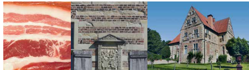
Die typische „Specklage“ an der Fassade des Mervelder Hofes.
